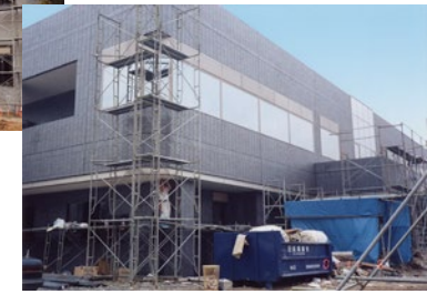
平成元年 浦安鉄鋼会館の建設
