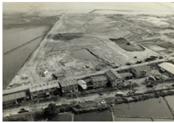
昭和41年 埋立地風景 現場工事事務所
